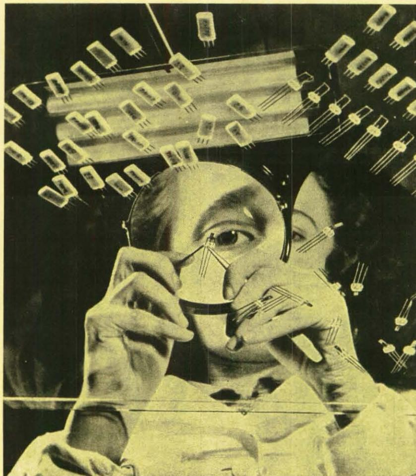
So winzig sind die Kristalle, daß sie nur mit Hilfe einer Pinzette und eines Vergrößerungsglases in den Transistor eingesetzt werden können. Hier haben wir es mit Germaniumkristallen zu tun, die in dem kleinen Transistorgerät den Fluß der Elektronen verstärken und steuern, ohne dabei selbst — in irgendeiner Form — Energie zu verbrauchen.
