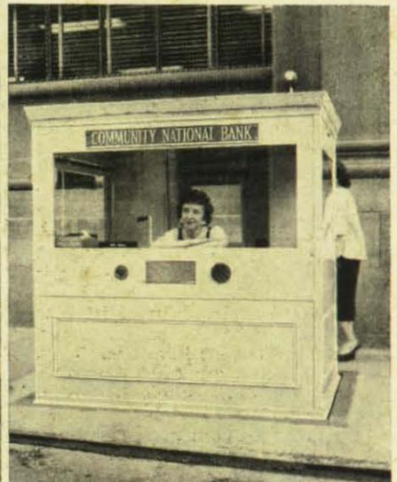
Mit Hilfe einer Spiegelanlage sehen sich hier an einem amerikanischen Autoschalter Kundin und Kassierer. Der Bar-mann sitzt zwei Meter unter dem Straßenniveau. Die gleiche Anlage läßt sich auch für einen hochliegenden Kassenraum bauen. Wertpapiere und Geld gelangen mittels eines kleinen Aufzuges von der Hand der Kundin in die Hand des Kassierers und umgekehrt. Dieser Schalter bietet große Sicherheit.
