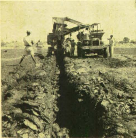
Die Ausbeutung des Sees ist denkbar einfach. Mit modernen Maschinen wird der Boden aufgedrückt und in bereitstehende Kippwagen verladen. Bild unten: Früher wurde der Asphalt nur mit Schaufel und Haue sehr mühevoll abgebaut.
