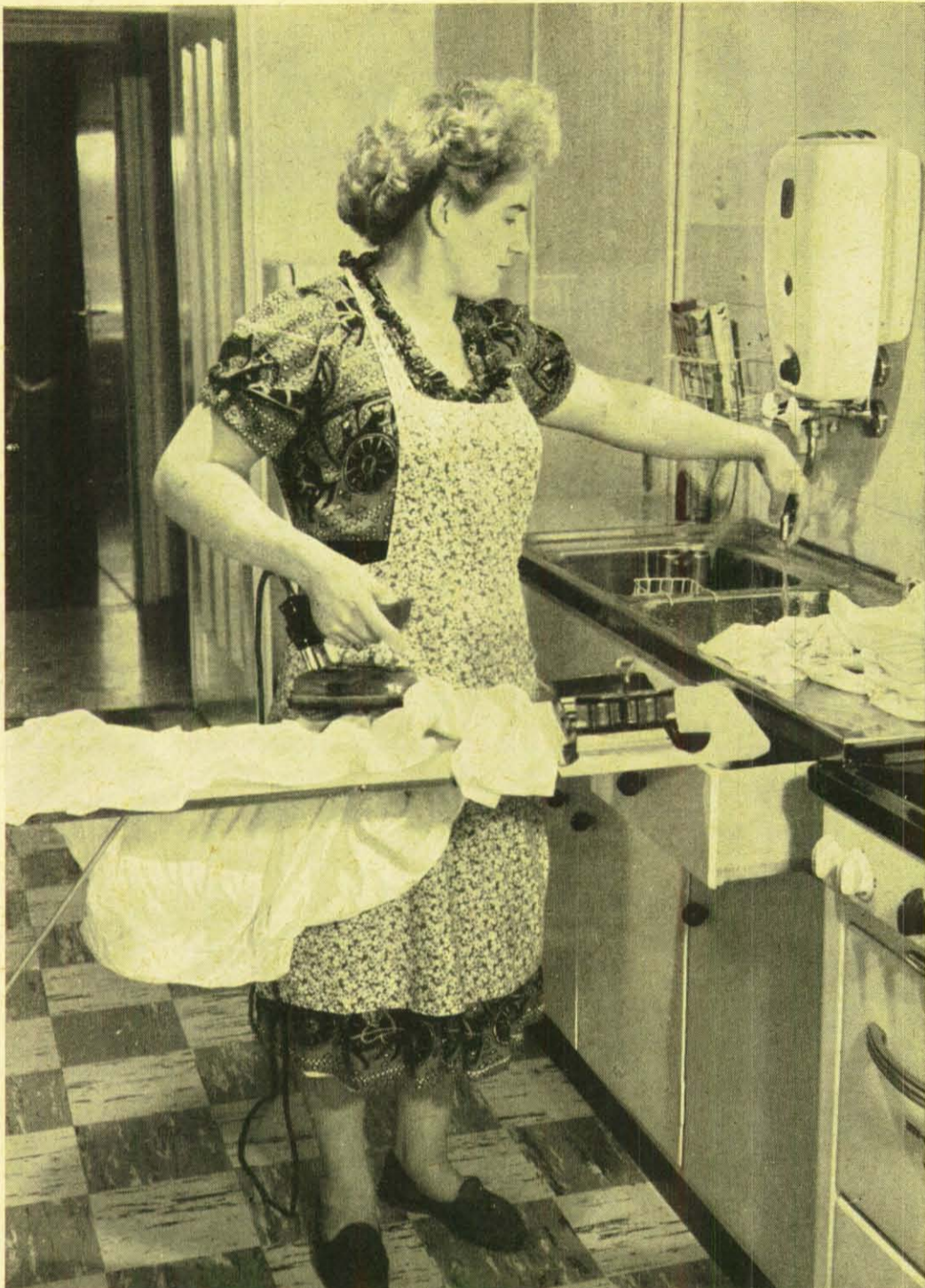
◀ Selbstmörderisch geht diese Hausfrau vor, weil sie beim Bügeln einen nicht geerdeten Zwischenstecker benutzt. Wenn sie nun noch den Wasserhahn anfaßt, um die Wäsche einzusprengen und dazu auf einem leitenden Küchenfußboden steht, kann es schon beim geringsten Defekt des Bügeleisens zum schlimmsten Unglück kommen.
