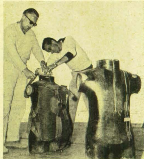
Als Schneidertuppen aus Gummi könnten man diese Torsos bezeichnen. Sie zeigten sich für die Lösung des Fallschirmabprungs aus großen Höhen als unentbehrliche „stumme Helfer“ des Menschen.
