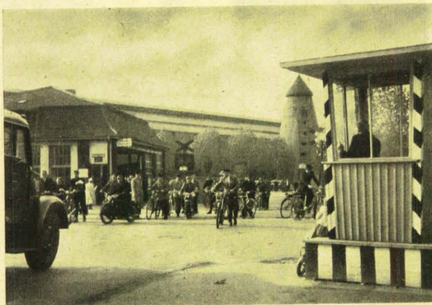
Der spitzhaubige Turm im Hintergrund des Bildes ist einer der in den Jahren des zweiten Weltkrieges bewährten Luftschutz-Sonderbauten, diesmal nicht zum Schutz des Arbeitsplatzes, sondern zum Schutz der arbeitenden Menschen mitten im Fabrikgelände erstellt. Er ist nicht der einzige, der die Feuerprobe im zweiten Weltkrieg heil überstand.
