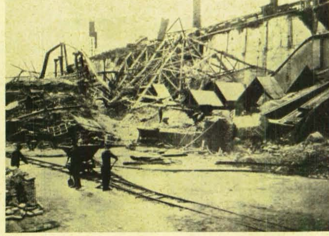
Ein solches Bild spricht für sich. Die Werkshallen sind zusammengestürzt, aber die Schutzdächer über den Maschinen haben gehalten. Die Arbeit konnte nach verhältnismäßig kurzer Unterbrechung wieder aufgenommen werden.
