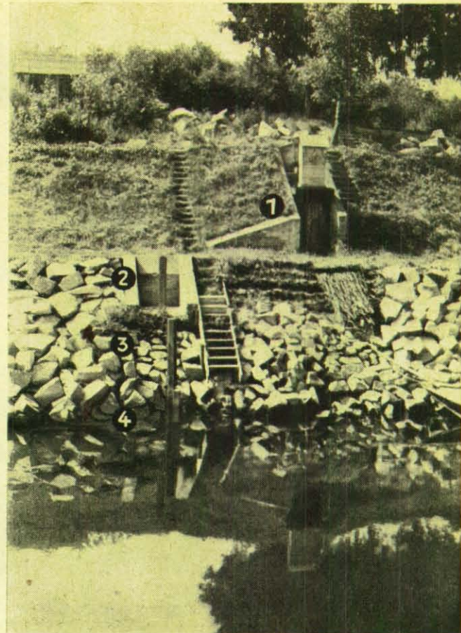
Vier Pegel hat die Wertach unterhalb der neuen Stauanlage. Nr. 1 und 2 wurden noch in Beton ausgeführt. Bei 3 und 4 nahm man schon Holzstempel. So schnell vertieft dieser regulierte Fluß sein Bett durch Erosion-Ausnagung.
