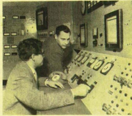
Blick in den Leitstand , in dem die Bedienungs- und Überwachungsgeräte zentral zusammengefaßt sind. Hier sitzt der Reaktor-Operateur, der den Reaktor steuert.
