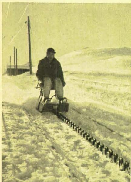
Die Zahnstange ist zunächst von hart gepreßtem Schnee und von Eis befreit worden (siehe Titelbild). Dann wird noch der Schnee links und rechts der Zahnstange mit einem eigenartigen Schlittenpflug beseitigt.
