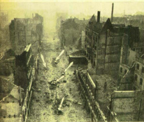
In dieser Hamburger Hauptverkehrsstraße hatte sich eine Feuerbereitschaft festgefahren, die anschließend auch noch verschüttet wurde.
