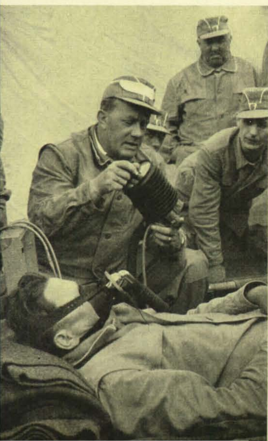
Der Luftschutzsanitätsdienst hat als Hilfsmittel moderne, zweckmäßige Geräte. Der handbetriebene Beatmer hilft, die Lungen- und Atemtätigkeit wieder in Gang zu bringen.
