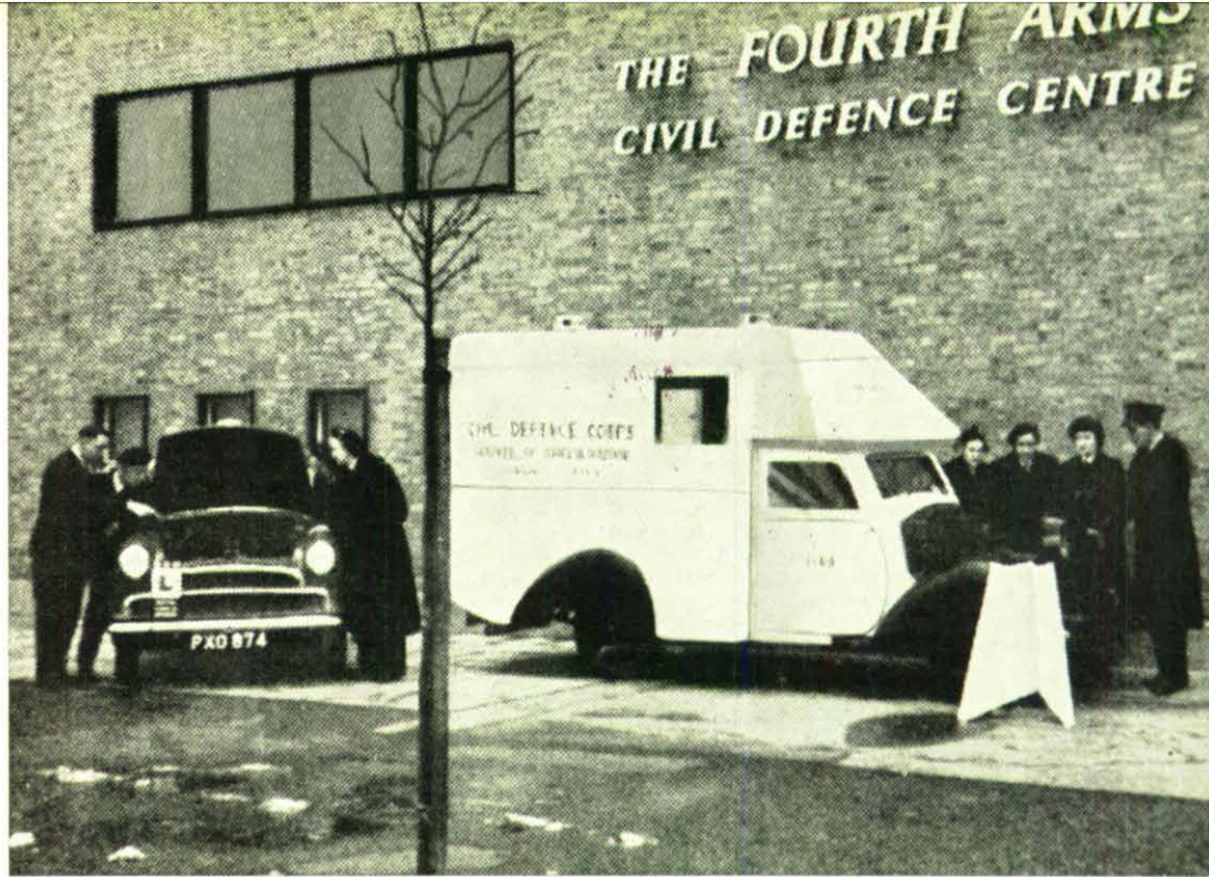
Bis 1954 war dieses Haus Sitz des britischen Presseklubs. Seit fünf Jahren ist in ihm das Befehls- und Ausbildungszentrum der „vierten Waffe“, die englische Zivilverteidigung, untergebracht. Diese dem Innenminister unterstellte Organisation umfaßt den Selbst- und Industrieschutz und das Zivilverteidigungskorps.
