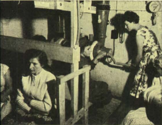
Wenn beim Aufenthalt im Schutzraum die Stromzufuhr aussetzt, kann das Belüftungsgerät auch gut von Frauen bedient werden.
