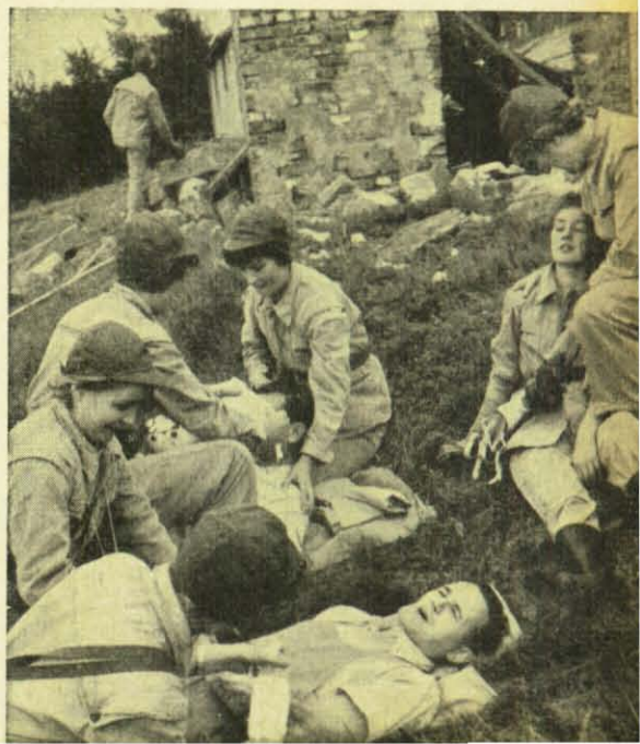
Für die Behandlung Verletzter sind Frauen besonders geeignet. Hier wird die erste Versorgung mit einfachen Mitteln vorgenommen.
