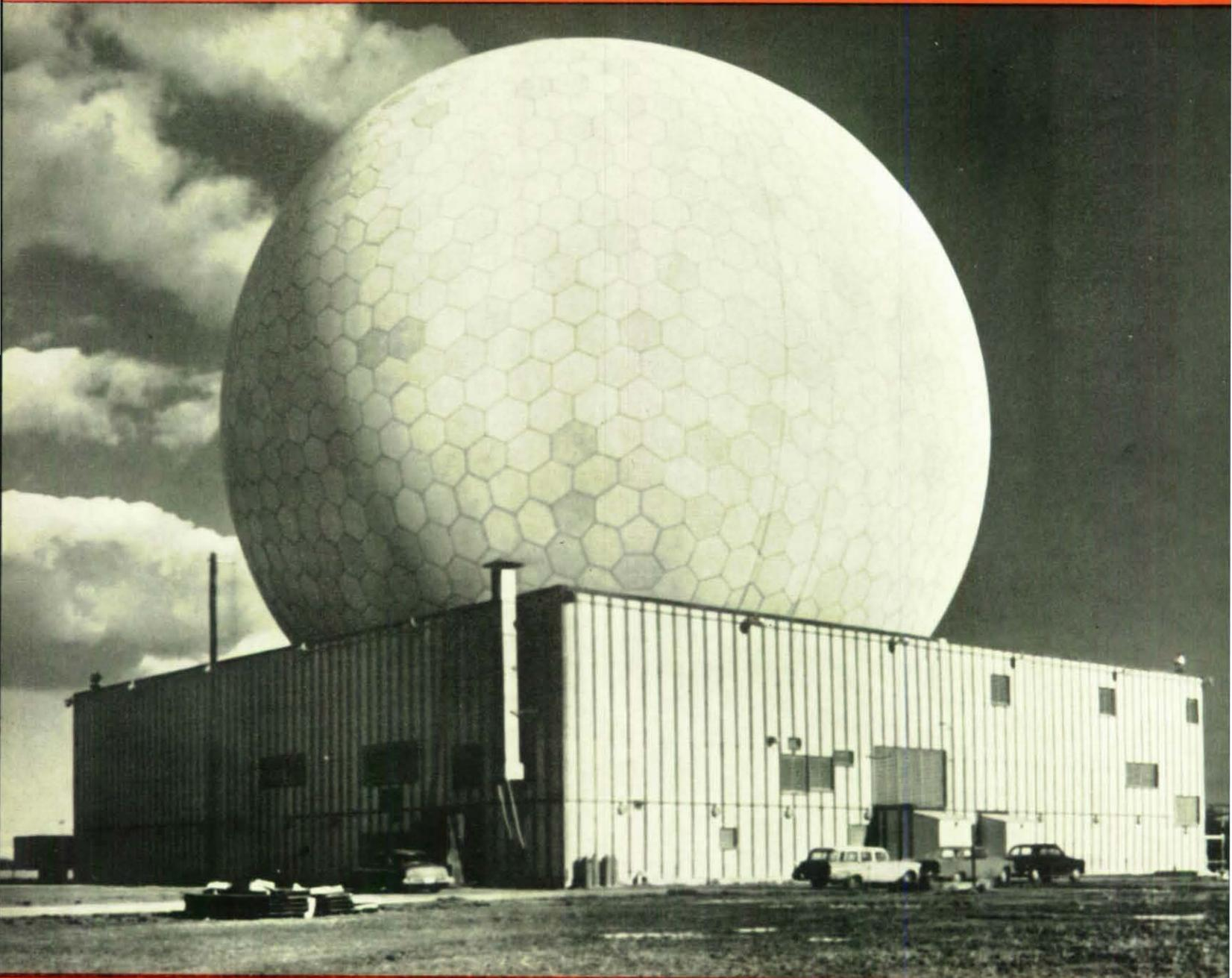
3000 Kilometer Reichweite hat die hochempfindliche Radarantenne, die sich hinter dieser schützenden Kunststoffhülle dreht. Sie gehört zu dem Raketen-Frühwarnsystem der USA, durch das im Falle eines Raketenangriffs auf die Vereinigten Staaten eine Warnfrist von 15 Minuten ermöglicht wird.
