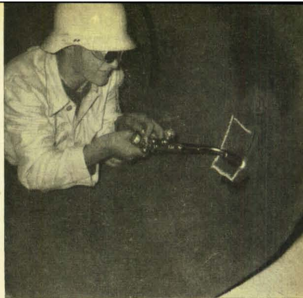
Die Ausbildung im Technischen Hilfswerk ist hervorragend. Schweißarbeiten zum Beispiel werden auch unter den schwierigsten Bedingungen immer wieder geübt und gemeistert.
