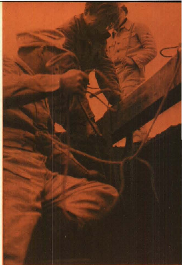
Bild oben: Die Treppen des „Trümmerhauses“ sind zerstört. Aus Balken und Leinen wird im zweiten Stock die Abseilvorrichtung angebracht, mit deren Hilfe die Betroffenen sicher zur Erde geschafft werden können. — Bild unten: Einsturzgefährdete Mauern müssen abgestützt und eingefallene Decken mit Bohlen überbrückt werden. Ohne Verzögerung können die „Verletzten“ nun geborgen werden.
