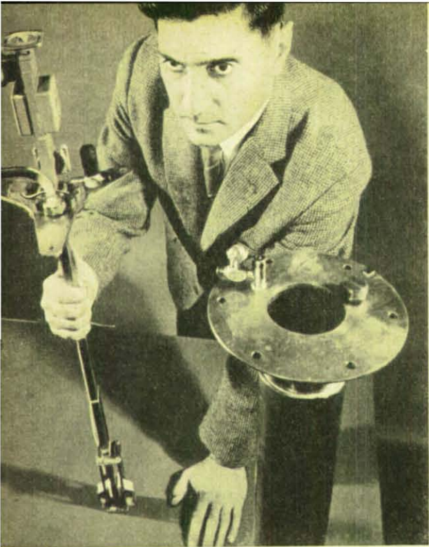
Der Rubin-Maser wiegt nur 12 kg. Rubin und Dauermagnet (am unteren Ende des Gerätes, links im Photo) werden in den Kühlbehälter (rechts) eingesetzt, wo der synthetische Rubin auf minus 269 Grad Celsius gekühlt wird.
