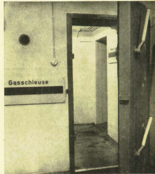
Noch einmal der Schutzbau der Feuerwache: Oben die Gasschleuse und eine der 9-türigen Türen, unten Schlaf- und Sitzgelegenheiten.
