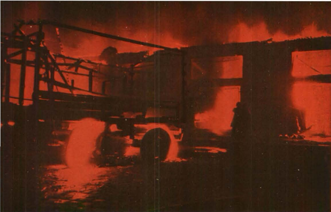
Totalbrand eines Großbetriebes. Hier war, da das Dach schon ganz in Flammen stand, nur noch ein Außenangriff möglich und die Absicherung der umliegenden Gebäude.
