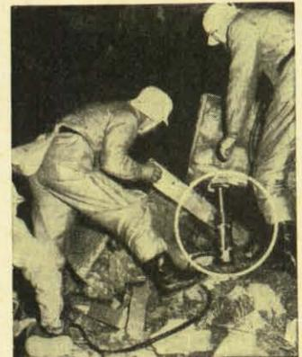
Das Universal Hydro-Werkzeug LUKAS hat sich im Einsatz bei allen Arbeiten bewährt, für die hohe Druck- oder Zugkraft notwendig ist. Einige Anwendungsbeispiele: Abstützen von Trägern, Mauern usw.; Anheben von schweren Lasten; Aufgleisen von Schienenfahrzeugen; Biegen dickwandiger Rohre; Schieben, Ziehen und Heben von Brücken- oder Gebäudeteilen, Steinblöcken und allen anderen schweren Lasten usw. Unser LUKAS-Handbuch gibt Ihnen wertvolle Anregungen. Sie erhalten es kostenlos.
