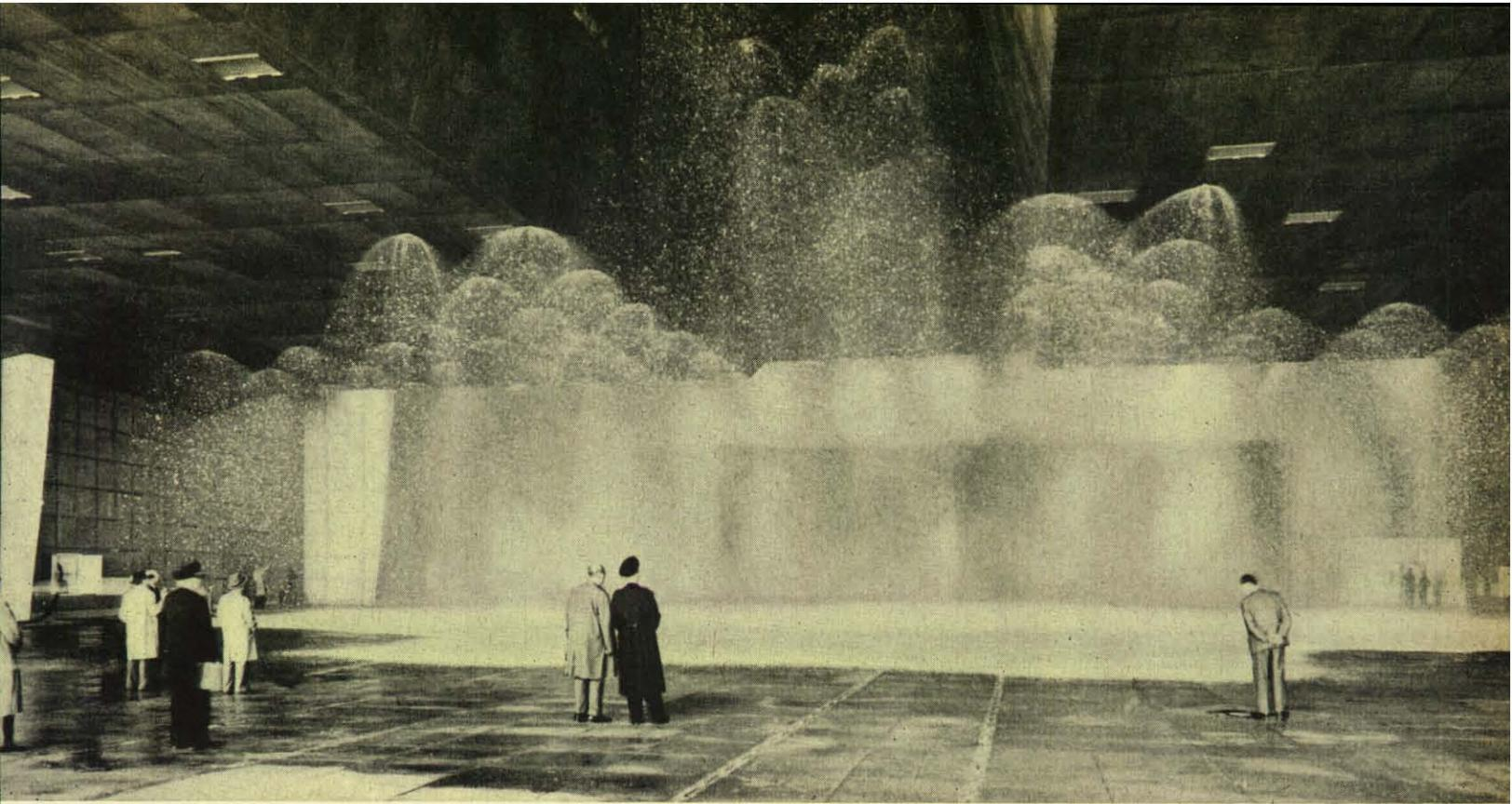
Die „Stationäre Luftschaumanlage“ der Lärmschutzhalle des Flughafens Fuhlsbüttel wird von der Hamburger Berufsfeuerwehr abgenommen. Unten: Die Luftschaumanlage ist abgeschaltet. Deutlich sind die Schaumdüsen an der Decke zu erkennen. Links auf dem Foto wird ein einzelnes Handschaumrohr vorgeführt. Auf dem Boden liegt eine dicke Schicht.
