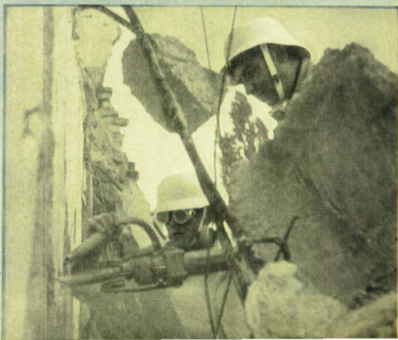
Links: Hölzer, zum Abstützen von Mauerwerk oder Decken, die infolge Zerstörung einzustürzen drohen, werden schnell mit der leichten Ein-Mann-Motorsäge auf Maß geschnitten. Unten: Ist Eile geboten, um an Verschnittene heranzukommen oder sie mit Sauerstoff zu versorgen, wird zu Mauerdurchbrüchen ein Gesteinsbohrhammer eingesetzt.
