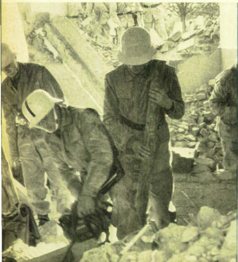
Links: Hölzer, zum Abstützen von Mauerwerk oder Decken, die infolge Zerstörung einzustürzen drohen, werden schnell mit der leichten Ein-Mann-Motorsäge auf Maß geschnitten. Unten: Ist Eile geboten, um an Verschnittene heranzukommen oder sie mit Sauerstoff zu versorgen, wird zu Mauerdurchbrüchen ein Gesteinsbohrhammer eingesetzt.
