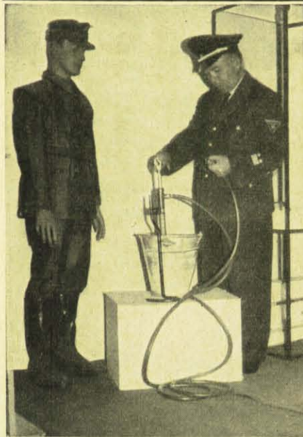
Die Einstellspritze fand das Lob eines Fachmanns: Oberbaurat Wischer, Brandschutz-Dezernent und Chef der Städtischen Feuerwehr von Regensburg. Klein, aber wirkungsvoll kann die Spritze bei der ersten Brandbekämpfung mit Erfolg eingesetzt werden.
