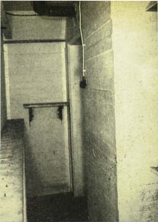
An allen Wand- und Deckenbegrenzungen waren Streifen aus nachleuchtenden Farben angebracht, die bei Stromausfall eine gute Orientierung im Schutzraum ermöglichen sollten.
