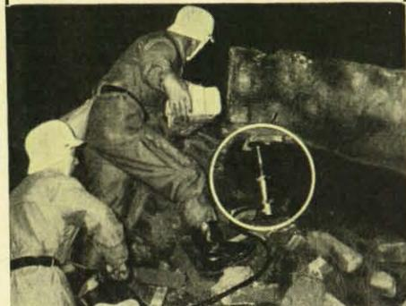
Das Universal-Hydro-Werkzeug LUKAS hat sich im Einsatz bei allen Arbeiten bewährt, für die hohe Druck- oder Zugkraft notwendig ist. Einige Anwendungsbeispiele: Räumen von Trümmern (s. Bild); Abstützen von Trägern, Mauern usw.; Anheben von schweren Lasten; Aufgleisen von Schienenfahrzeugen; Biegen dickwandiger Rohre; Schieben, Ziehen und Heben von Brücken- oder Gebäudeteilen, Steinblöcken und allen anderen schweren Lasten.
