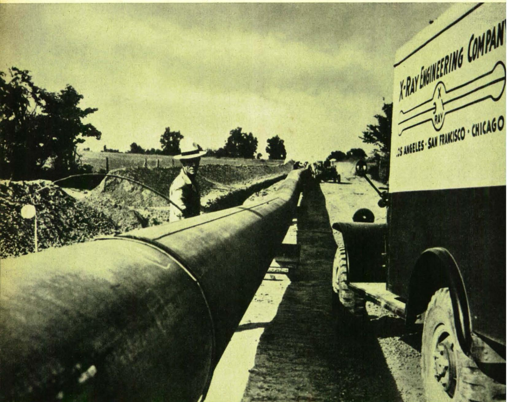
Radioaktives Kobalt liefert hier anstelle einer Röntgenröhre, die überdies nur mit einer Hochspannungsanlage betrieben werden könnte, die durchdringende Strahlung zur Prüfung von Schweißnähten an einer großen Rohrleitung. Über 550 amerikanische Unternehmen verwenden heute schon Radioisotope für Zwecke der Werkstoffprüfung.
