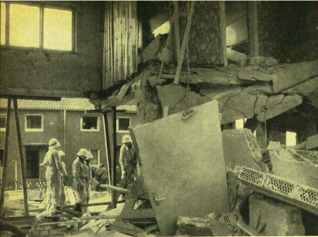
Auch dieses Haus wurde durch eine Gasexplosion schwer zerstört. Die stark beschädigten Mauern wurden abgestützt, um Bergungshelfer bei der Arbeit nicht zu gefährden.
