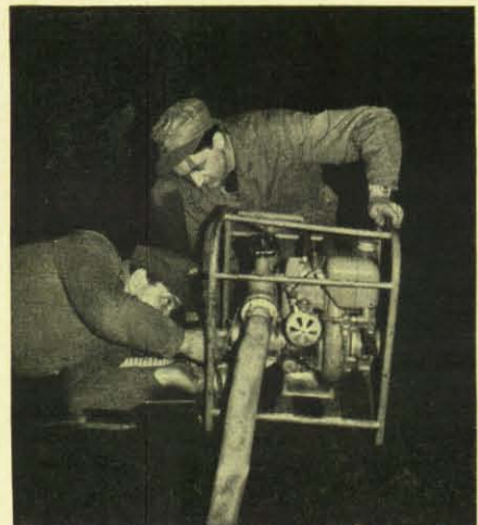
Oben links: THW-Helfer tragen ein Notstromaggregat an die Einsatzstelle. Oben rechts: Als die Flut abgelaufen war und die Abwasserkanäle wieder Wasser aufnahmen, setzte die Feuerwehr alle verfügbaren Pumpen zum Entleeren der Keller ein. Links: BLSV-Helfer beim nächtlichen Einsatz. Hier wird der Saugvorgang gerade unterbrochen, weil sich das Sieb der Kreiselpumpe der TS 2/5 durch die im Wasser schwimmenden Fasern der Sandsäcke wieder zugesetzt hat.
