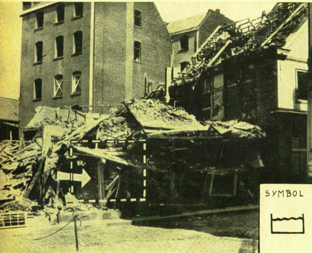
Der ausgegossene Raum. Mit Trümmern mehr oder weniger ausgefüllte Räume in Keller- und Erdgeschossen. Freilegen ist oft durch Einschnitt (s. Bildmitte) und Vortreiben von Stollen, auch aus Nachbarräumen, möglich. Abräumen von oben ist zeitraubend.
