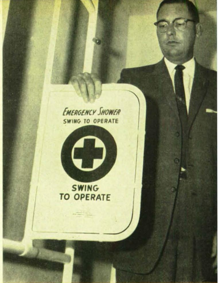
Oben links: Der Schulleiter bei der Kontrolle der Notstromanlage. Links im Bild ist ein Teil des Diesel-Aggregats zu sehen. Oben rechts: Diese Not-Duschanlage wird von Hand betrieben. Durch sie soll von radioaktivem Niederschlag befallenen Personen die Gelegenheit zur Körperwäsche gegeben werden. Unten: Aus der Luft gesehen. Die Eingänge zu dieser einzigartigen Kombination von Schule und Schutzraum befinden sich unter den oberirdischen Aufbauten im Vordergrund.
