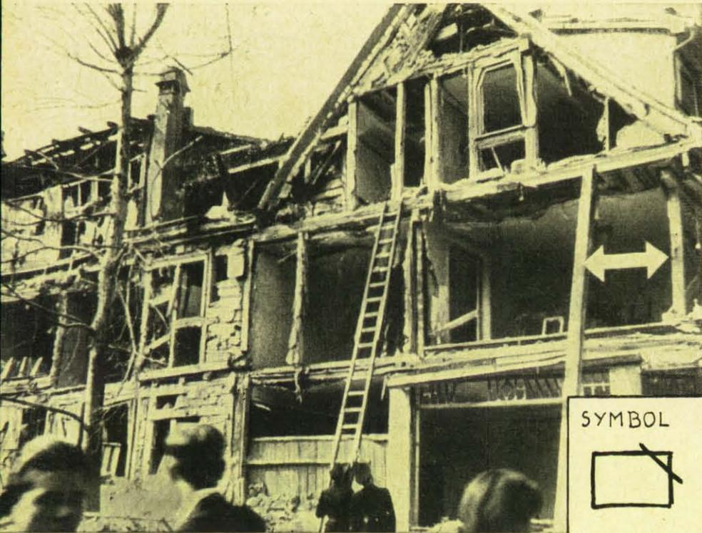
Der angeschlagene Raum. Am häufigsten durch Druckwirkung verursacht, besonders in Fachwerk- und Stahlbetongerippebauten. Räume sind oft nach einfachen Sicherungen (s. im Bild rechts) betretbar. Auf gelockerte Verbindungen achten!
