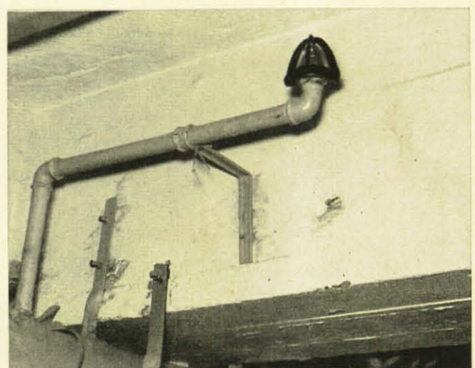
Oben: Blick in die Zentrale einer Sprinkleranlage. Bei Alarm ist eine Menge Handgriffe auszuführen. Eine große Tafel führt die Reihenfolge dieser Maßnahmen genau auf. Unten: Sprinkler schalten sich selbsttätig ein, wenn die Temperatur in einem Raume aus irgendeinem Grunde auf 62° C gestiegen ist.
