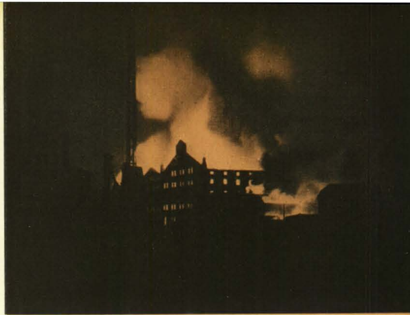
Nächtliche Aufnahme eines Brandes in einem großen Warenhaus. Das ganze Gebäude steht in Flammen. Hier können nur die Nachbargebäude gegen ein Übergreifen geschützt werden.
