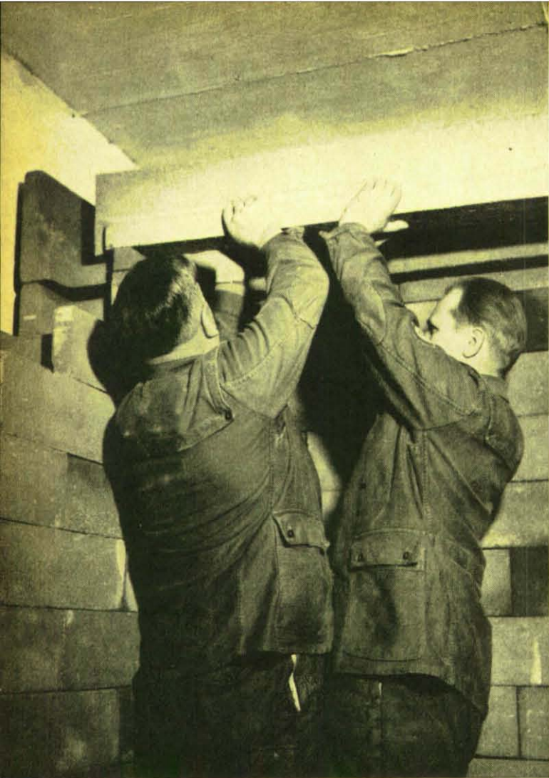
Hier wird die Decke aus Stahlbetonbalken aufgebracht, die aus Gründen des Strahlungsschutzes mit Beton verfüllt werden. Zwei Personen verrichten diese Arbeit.
