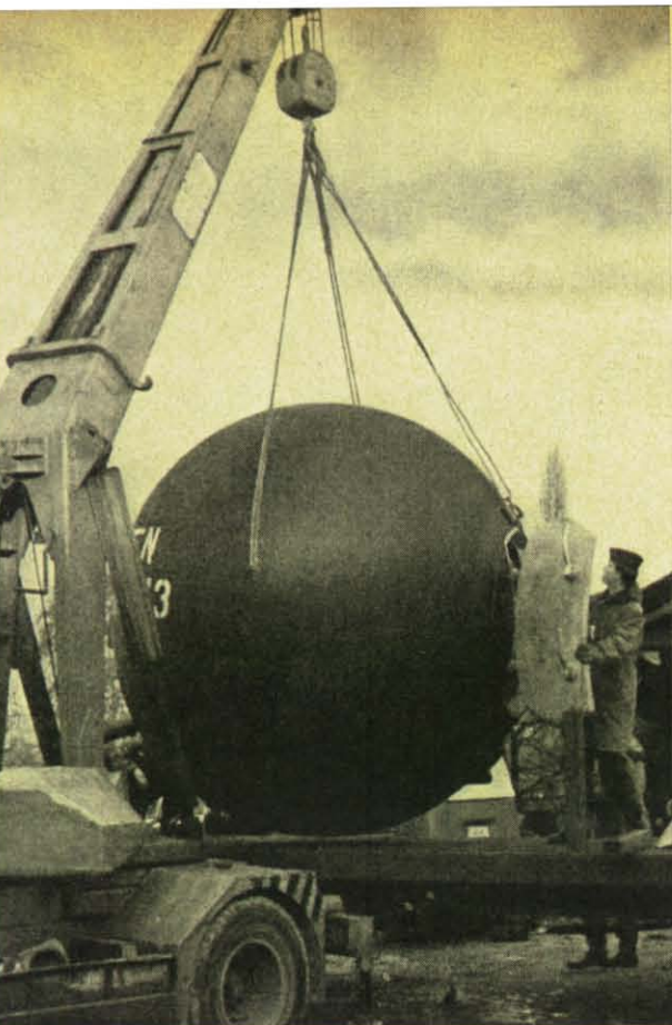
Oben: Ein einbaufertiger Kugelschutzraum auf einem Tieflader. Daneben: Schematische Darstellung der Einrichtung und Besetzung. Rechts: Montage der einzelnen Kugelkalotten. Darunter: Transport der fertigen Kugel zu ihrem Einsatzort.
