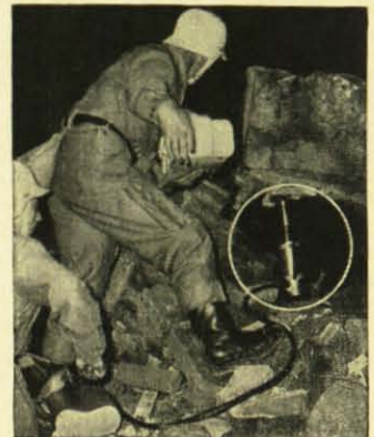
Abb.: Räumen von Trümmern mit LUKAS
