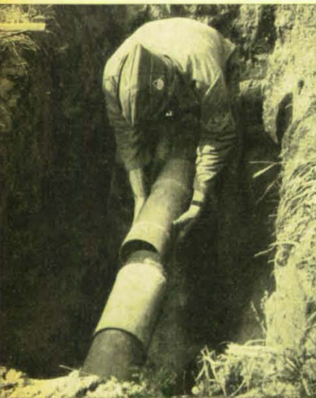
Unten links: Vorbereitung für den Schweißvorgang. Daneben: Ein U-Rohrmanometer, der während der Arbeiten den Gasdruck in der Rohrleitung überwacht. Mit einer Bitumenbinde werden die Schweißnähte isoliert.
