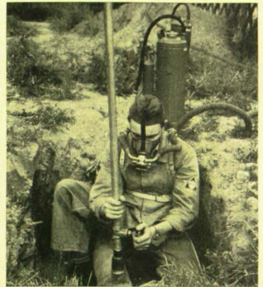
Bild unten: Hier sieht man, wie durch das Ausblaserohr die Gasleitung wieder entlüftet wird. Der THW-Helfer hat darum die Atemschutzmaske wieder angelegt.
