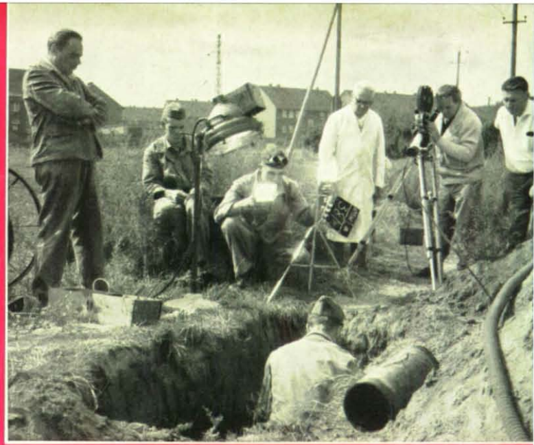
Oben links: Kein Schildbürgerstreich, sondern die Übungswand für die Duisburger Feuerwehr. Daneben sieht man Filmleute bei Dreharbeiten zu einem Lehrfilm des Technischen Hilfswerkes über die Beseitigung von Schäden an den Versorgungsleitungen.
