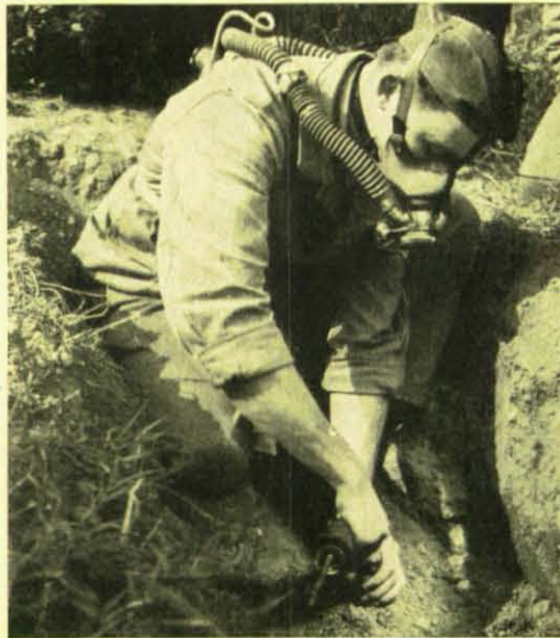
Unten links: Vorbereitung für den Schweißvorgang. Daneben: Ein U-Rohrmanometer, der während der Arbeiten den Gasdruck in der Rohrleitung überwacht. Mit einer Bitumenbinde werden die Schweißnähte isoliert.
