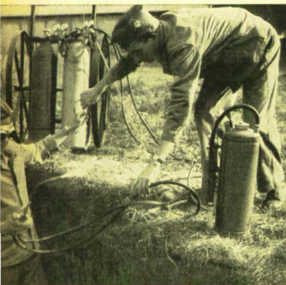
Unten links: Vorbereitung für den Schweißvorgang. Daneben: Ein U-Rohrmanometer, der während der Arbeiten den Gasdruck in der Rohrleitung überwacht. Mit einer Bitumenbinde werden die Schweißnähte isoliert.
