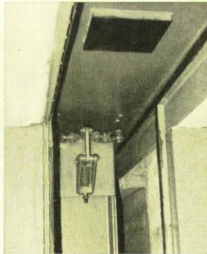
In Wiesbaden fand erstmalig eine Spezialkonstruktion für das große Druckschiebetor Anwendung. Die beiden Bilder zeigen die Hebelvorrichtung, die beim Absenken in Wirkung tritt. Eine zweite über Schraubenspindel betätigte Verriegelung hält das Tor in der Gegenrichtung fest.
