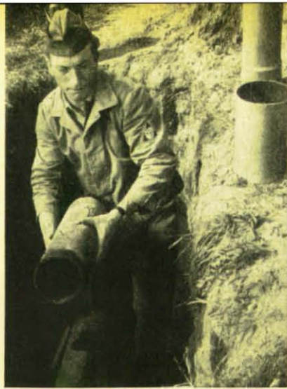
Oben von links nach rechts: Setzen einer Gasblase, am Modell demonstriert. Beseitigung des schadhaften Rohrteiles und Vorpassen des neu einzubauenden Rohrstückes am Modell. Darunter links außen: Herstellung einer neuen Rohrverbindung mittels vorgefertigten Rohrendes und Überschiebmuffe. Daneben: Die Gasabsperrröhre wird wieder entfernt.
