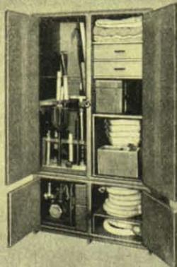
zur Aufnahme einer kompletten Ausrüstung für die Mindesteinsatzkräfte (Brandschutz-, Rettungs- und Laienhelfertrupp) oder der Geräte einer Rettungs- und Laienhelferstaffel des Erweiterten Selbstschutzes (Behörden und Industrie) nach Ausrüstungsnachweis BzB bzw. BLSV.
