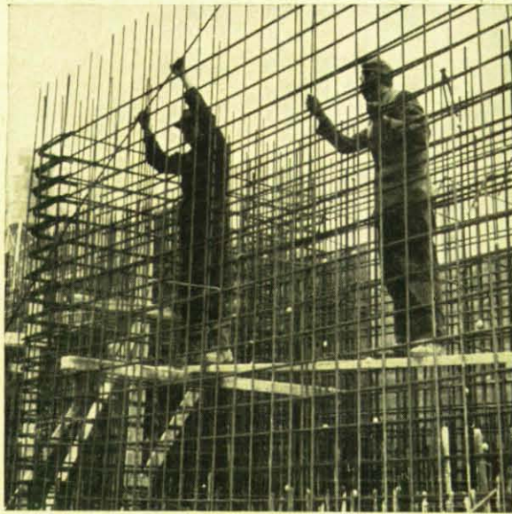
Mitte links: Das Errichten der hölzernen Verschalungswände in dem scheinbaren Gewirr aus Betoneisen läßt das Fortschreiten der Arbeiten erkennen. Unten: Schweißarbeiten an der Armierung. Rechts: Ein „Schutzraumskelett“ entsteht.
