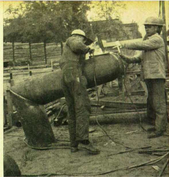
Links: Bauarbeiten an einer zukünftigen U-Bahn-Station. An einem der Hauptverkehrspunkte in Frankfurt entsteht eine große unterirdische Parkanlage (oben und Mitte), die gleichzeitig für Zwecke des Zivilschutzes ausgebaut wird. Die Bilder zeigen die Arbeiten an der Armierung, das Schweißen der Be- und Entlüftungsrohre vor ihrem Einbau.
