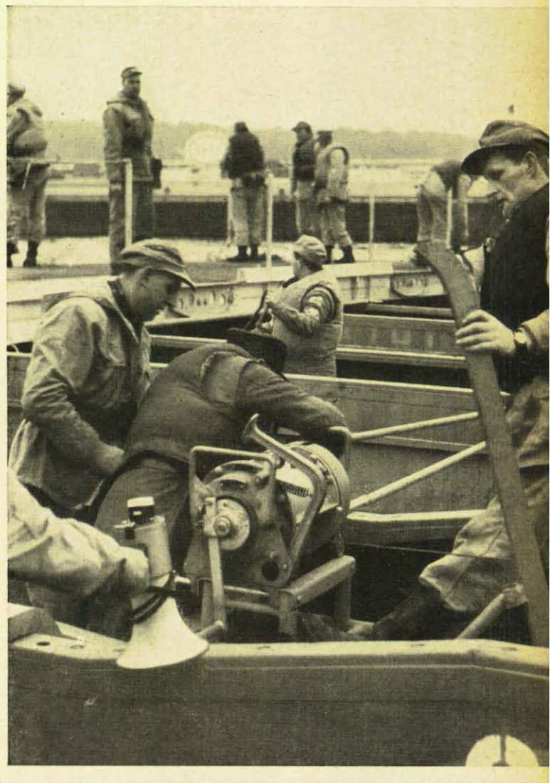
Fähren zu bauen ist keine leichte Sache. Jeder Handgriff, wie hier bei der Montage der Ankerwinde, muß sitzen. Die Gäste der Katastrophenschutz-Übung auf dem Rhein bei Leverkusen konnten sich von der Einsatzbereitschaft und dem Können der THW-Helfer überzeugen.
