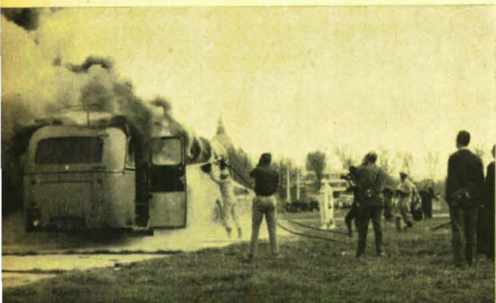
Oben: Bei einem (angenommenen) Unfall riß der Tank dieses Omnibusses auf, durch Kurzschluß geriet der Treibstoff in Brand. Das Feuer breitet sich über den ganzen Wagen aus. Bekämpfung durch Einsatz zweier Löschpulver-Anhänger mit je 250 kg Füllung. Unten: Ein brennender Personenwagen wird gelöscht.
