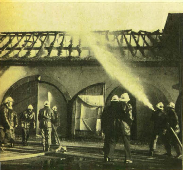
Oben: Wie realistisch die Übung geplant war, zeigt dieses Bild. Die Feuerwehr von Saargemünd bekämpft einen Brand in der alten Feuerwehrkaserne. Unten: Als ein unerschöpfliches Reservoir bot sich für die Brandbekämpfung die dicht vorbeifließende Saar an.
