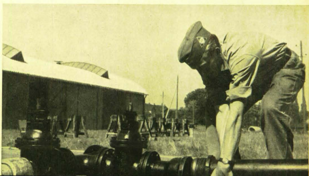
Ein Wasserrohr NW 100 aus Gußeisen mit Schraubmuffe wird (Bild unten links) zum Einbau vorbereitet. Deutlich sieht man den vor dem Muffenschraubring liegenden Gummidichtungsring. Daneben: Die vorbereitete Rohrlänge wird an das am Absperrschieber montierte E-Stück eingesetzt.
