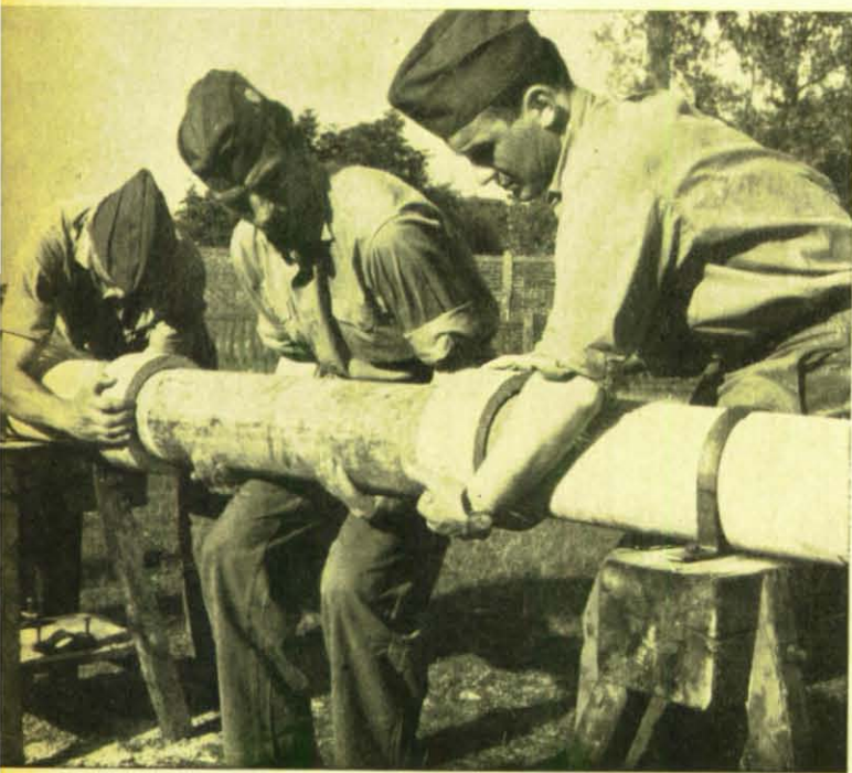
Die Wasserrohre werden zur Reparatur vorbereitet. Im Vordergrund sieht man die erforderlichen Werkzeuge, Geräte und Materialien (oben links). Anschließend wird das vorbereitete Ersatzstück (rechts oben) in die beschädigte Trinkwasserleitung eingebaut. Mitte: Das eingebaute Ersatzstück wird durch Kupplungen mit den Enden der Leitung verbunden.
