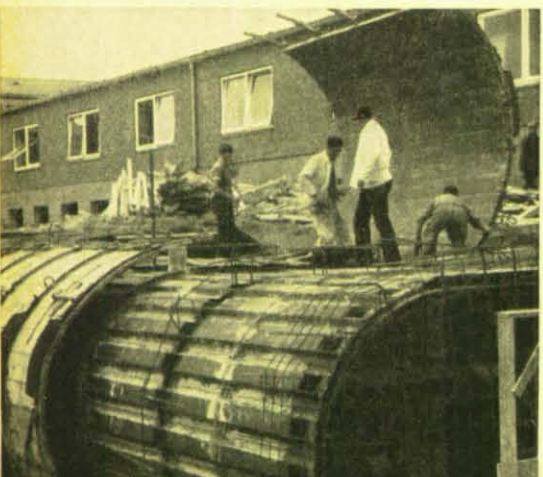
◀ Die Schalung wird eingesetzt. Nach Beendigung der Betonarbeiten und dem Ausschalen wird die Baugrube wieder verfüllt und verdichtet. Alle Stahlteile werden vorher konserviert. Am Schluß wird die notwendige Erdabdeckung als weiterer Strahlenschutz aufgebracht.
