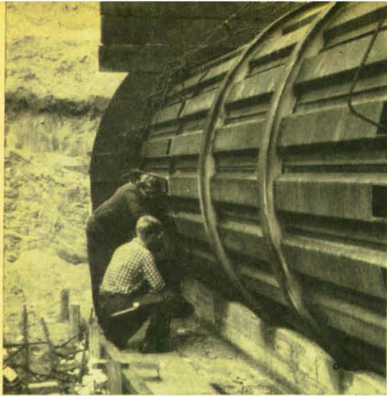
▲ Dieses Bild zeigt, wie der Stahlteil auf vorbereiteten Betonklötzen ruht. Die einzelnen Rahmen sind durch Hutbleche miteinander verbunden worden. Jetzt sind Arbeiter damit beschäftigt, die Abstandshalter anzubringen.
