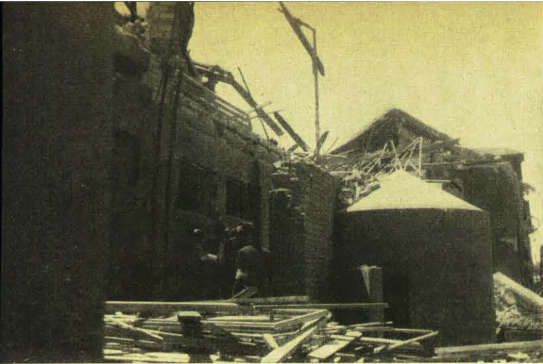
So sah es nach einem Sprengbombentreffer aus. Die Trafostation war durch eine 50 cm starke Splitterschutzwand gesichert und blieb unzerstört. Der Schutzstand für die Brandwache (rechts im Vordergrund) hielt stand, die Insassen blieben unverletzt.
