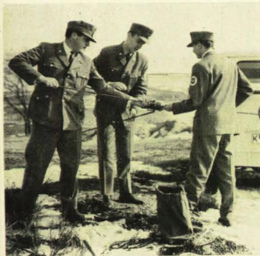
Die Antenne der beweglichen Funkleitstelle wird zusammengesteckt. Sende- und Empfangsleistung im 4-m-Band werden dadurch um ein Vielfaches verstärkt.
