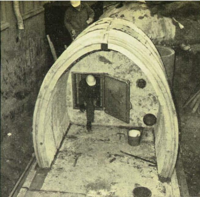
Links: Blick ins Innere mit der Verbindungsöffnung zum dahinterliegenden senkrechten (hier nicht sichtbaren) Notausstieg. Rechts hinten sind die zwei untersten Ringe des noch unfertigen Sandfilters zu sehen.
