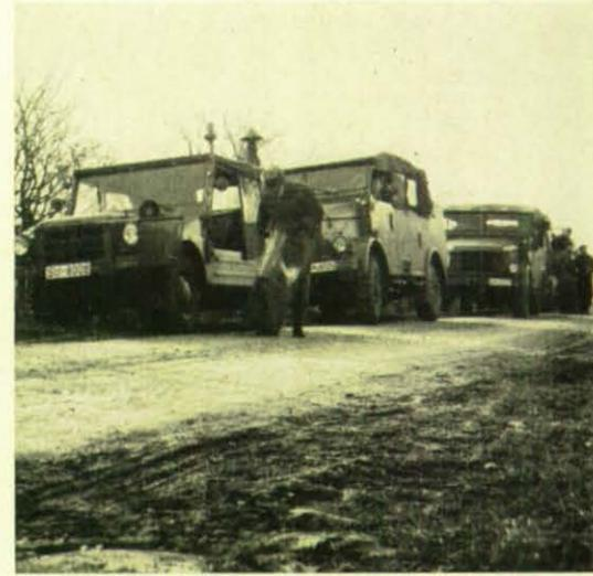
Der 52. LS-Fernmeldezug besteht aus Funkkommandowagen, Funkgruppenfahrzeug, zwei Fernsprechbauwagen, Lade- und Instandsetzungsfahrzeug, Feldkochherd.
