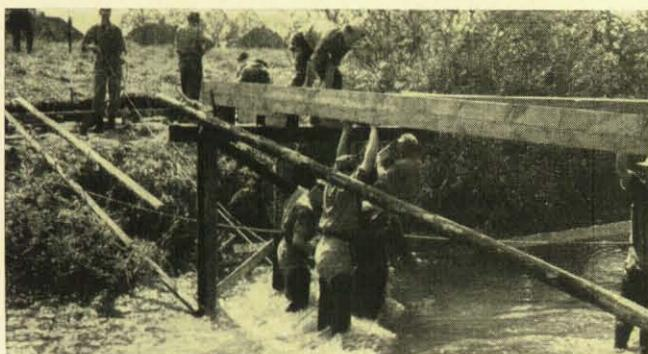
Kleinere Flüsse und Bäche werden von Behelfsbrücken überwunden. Hierbei verwendet das Technische Hilfswerk vorgefertigte Bauteile, die eine große Zeitersparnis bedeuten — vorausgesetzt, daß die handwerklichen Fähigkeiten der beim Bau eingesetzten Helfer durch Besuch von entsprechenden Lehrgängen an den THW-Schulen und durch praktische Übungen für diese spezielle Aufgabe gefördert wurden.
