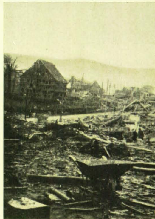
Die gesamte Fläche des Dorfes ist zerstört. Deutlich erkennbar ist die Ausfachung der Fachwerkbauten durch die Druckwirkung der im Mittelpunkt detonierten Minenbombe.
