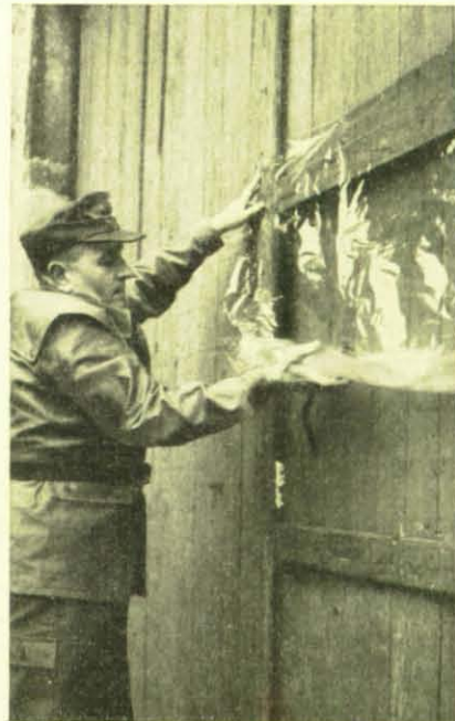
Türen, Fenster und Fensterläden werden geschlossen, Öffnungen mit Sandsäcken verbaut. Die Folienbespannung verhindert ein Eindringen des Staubes durch Undichtigkeiten.
