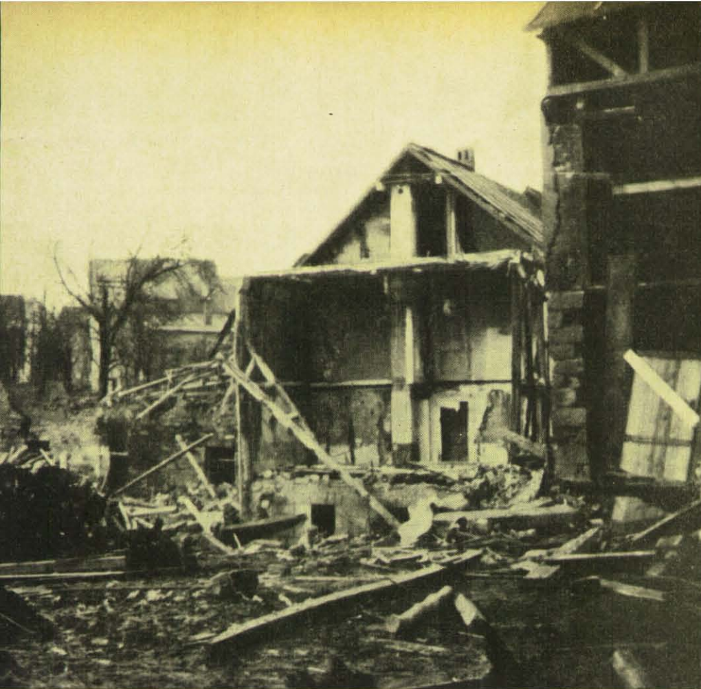
Das Schadensbild der zerstörten Gebäude (Rosbach) zeigt die bekannten Schadenselemente. Zerstörungsgrad und Verluste unterscheiden sich nicht von den Luftkriegsschäden in den Großstädten.
