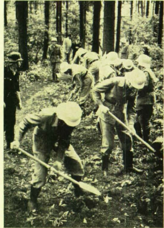
Boden- und Lauffeuer nehmen ihre Nahrung aus dem trockenen Unterholz, aus abgefallenen Ästen, Tannen-, Fichten- und Kiefernadeln. In Laufrichtung des Feuers müssen Gräben ausgehoben werden. Bei der Eile, die dann geboten ist, wird jede helfende Hand gebraucht.
