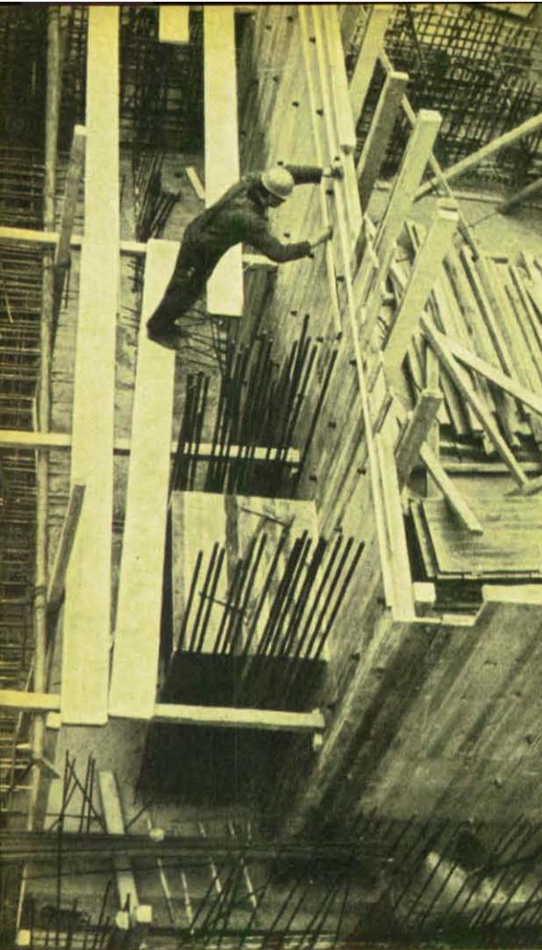
Für die Errichtung öffentlicher Schutzräume in Verbindung mit unterirdischen Verkehrsanlagen als Mehrzweckbauten wurden Richtlinien von den zuständigen Ministerien erlassen. So müssen Schutzbauteile und Umfassungsbauteile eine Schutzbewehrung aus Betonstahl erhalten.
