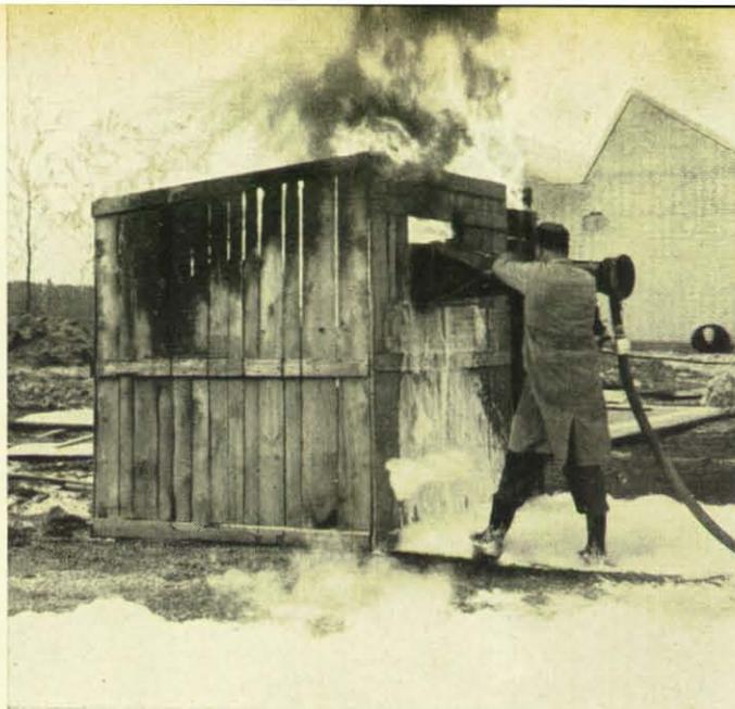
Für kleinere Löschaufgaben wurde dieses Leichtschamrohr entwickelt, das sich zur Brandbekämpfung durch Tür-, Fenster- oder Kelleröffnungen eignet.
