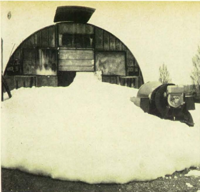
Je nach Verschäumungszahl fördert das Gerät 100 bis 200 cbm Schaum pro Minute. Hier quillt er durch eine undichte Stelle der bis unter das Dach mit Schaum gefüllten Baracke.
