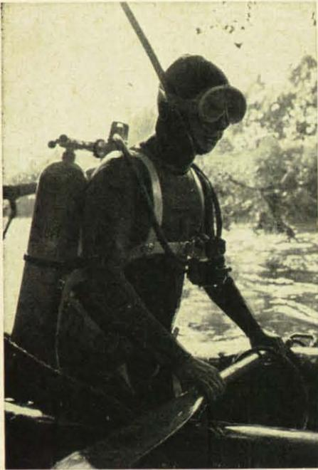
Bereit zum Eintauchen in das nasse Element. Den Kopf schützt die enganliegende Kopfhaube, die Augen die wasserdichte Taucherbrille. Auf dem Rücken des Tauchers die Flaschen mit Atemluft.
