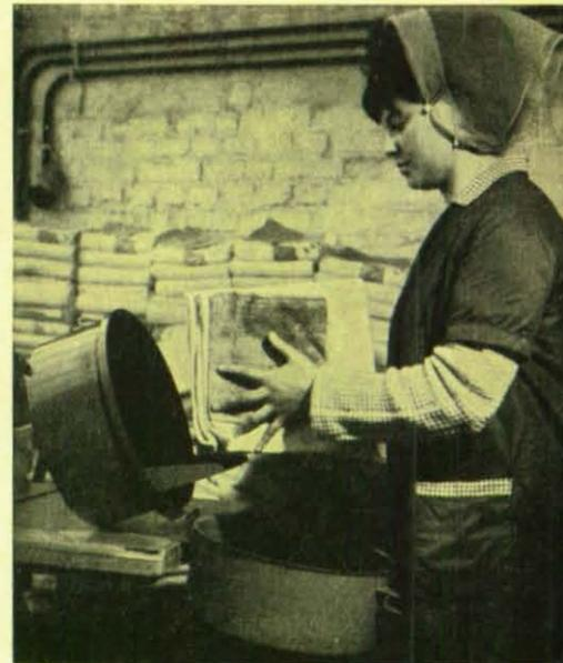
Für Feuerlöschdecken, die besonders ungünstigen klimatischen Verhältnissen ausgesetzt sind, wurde dieser Behälter gebaut. Er ist staub- und regensicher. Zwischen Deckel und Behälter befindet sich eine haltbare Dichtung aus Moosgummi. Auch dieses runde Modell läßt sich überall leicht anbringen.
