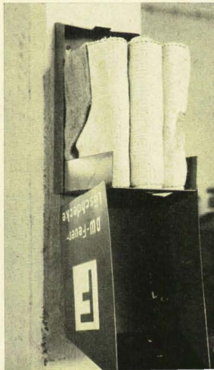
Diese Feuerlöschdecke wird in einem besonderen Behälter aufbewahrt. Er ist so konstruiert, daß der Deckel mit einem Handgriff heruntergeklappt werden kann. Blitzschnell können dann die Hände des Retters in die freiliegenden Griffaschen greifen.
