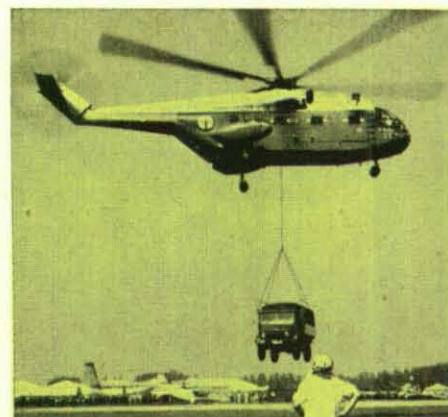
Der mit einem Lasthaken ausgerüstete Hubschrauber Sud Aviation „Superfrelon“ kann einen geländegängigen Lastwagen mit eingebauter Wasserfilteranlage – Gesamtgewicht 3,6 t – zum jeweiligen Einsatzort tragen.
