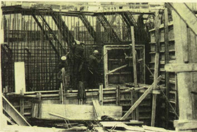
Die Belüftungsanlage des Schutzraumes (Bild ganz oben: Schutzbelüfter SL 0,75 mit wahlweise elektrischem und Handkurbelantrieb und Raumüberdruckmeßgerät) ist ebenso wichtig wie (unteres Bild) die Armierung der Betonwände.
