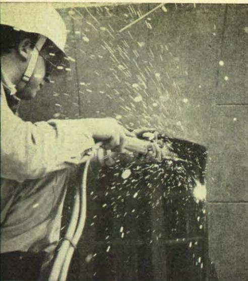
**Linke Seite, unten: Das Brennschneidgerät wird eiligst zum Einsatz vorbereitet.**
