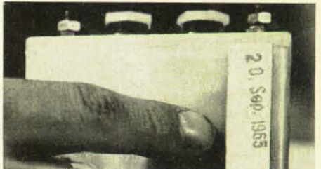
Klebestreifen auf der Batterie mit Datum der letzten Wartung.
