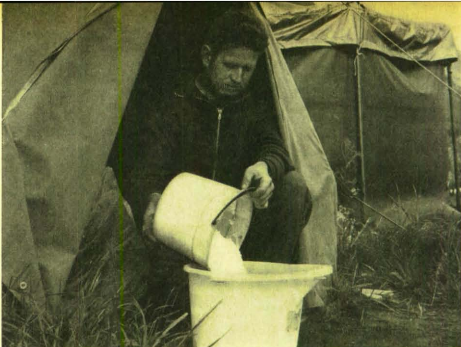
Bild 4: Das Anschwemmmaterial wird abgemessen und mit dem verschmutzten Oberflächenwasser aufgeschwemmt. Mit einer Pumpe wird diese Aufschwemmung zu den Anschwemmfiltern befördert. Nach Verschmutzung der Filtermasse wird diese abgespült und neue Filtermasse aufgebracht.
