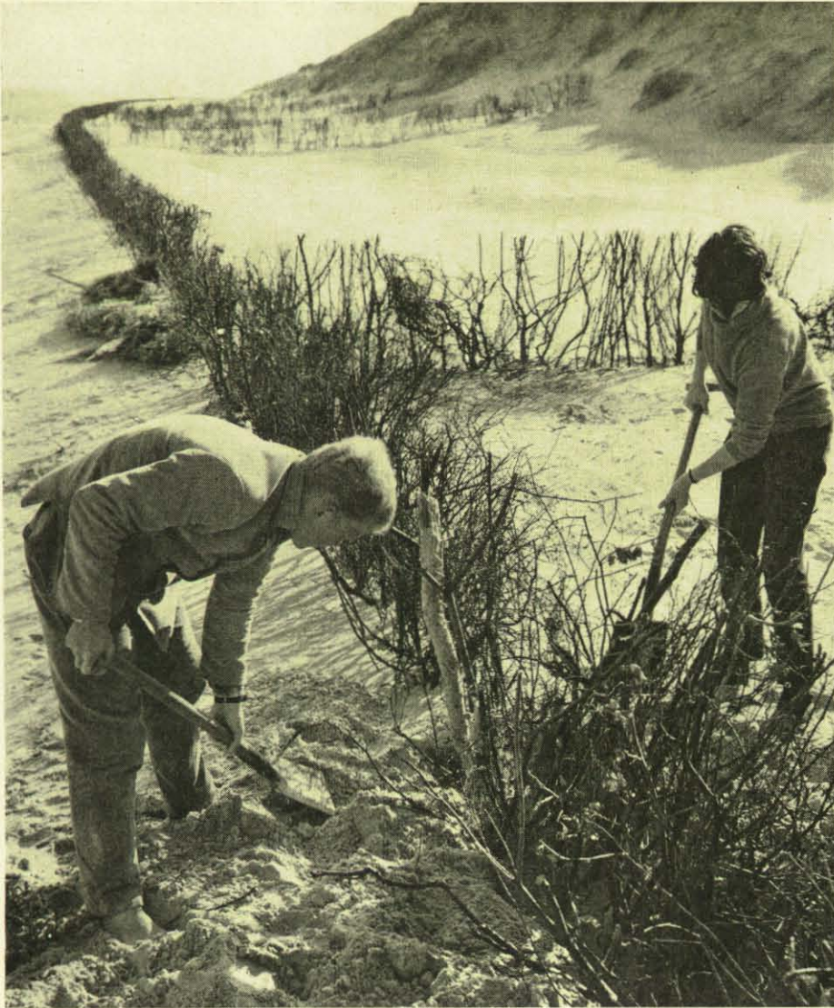
Oben: Lange Reihen eingegrabener Reisigzweige werden bald zu Sandwällen. Die richtige Streckenführung ist dabei wichtig.
