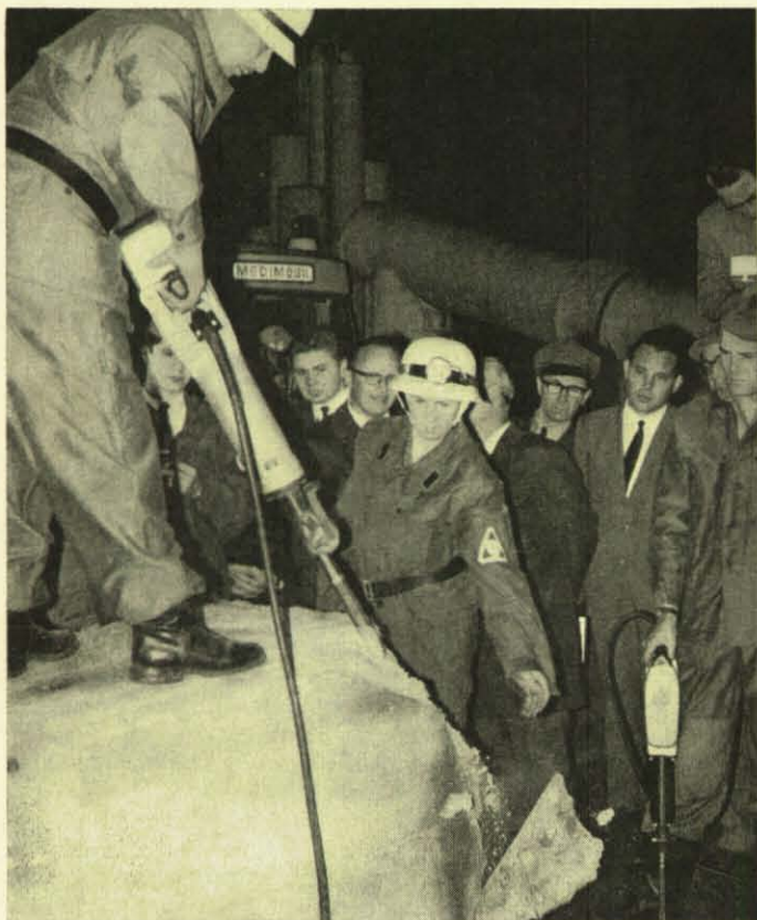
Unten: Die Demonstration der neuzeitlichen Geräte-ausrüstung des Zivilschutzes findet immer wieder großes Interesse. Hier wird mit einem Elektrohammer in kurzer Zeit ein Stahlbetonklotz zerlegt.
