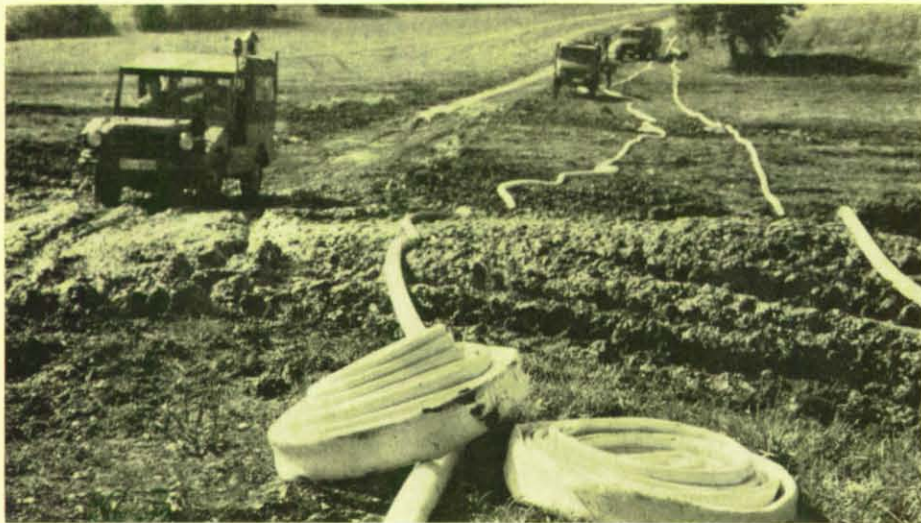
Oben: Auf der doppelten Förderleitung von vier km Länge mit Höhenunterschieden von 200 m wurden Verstärkerpumpen zwischengeschaltet.
