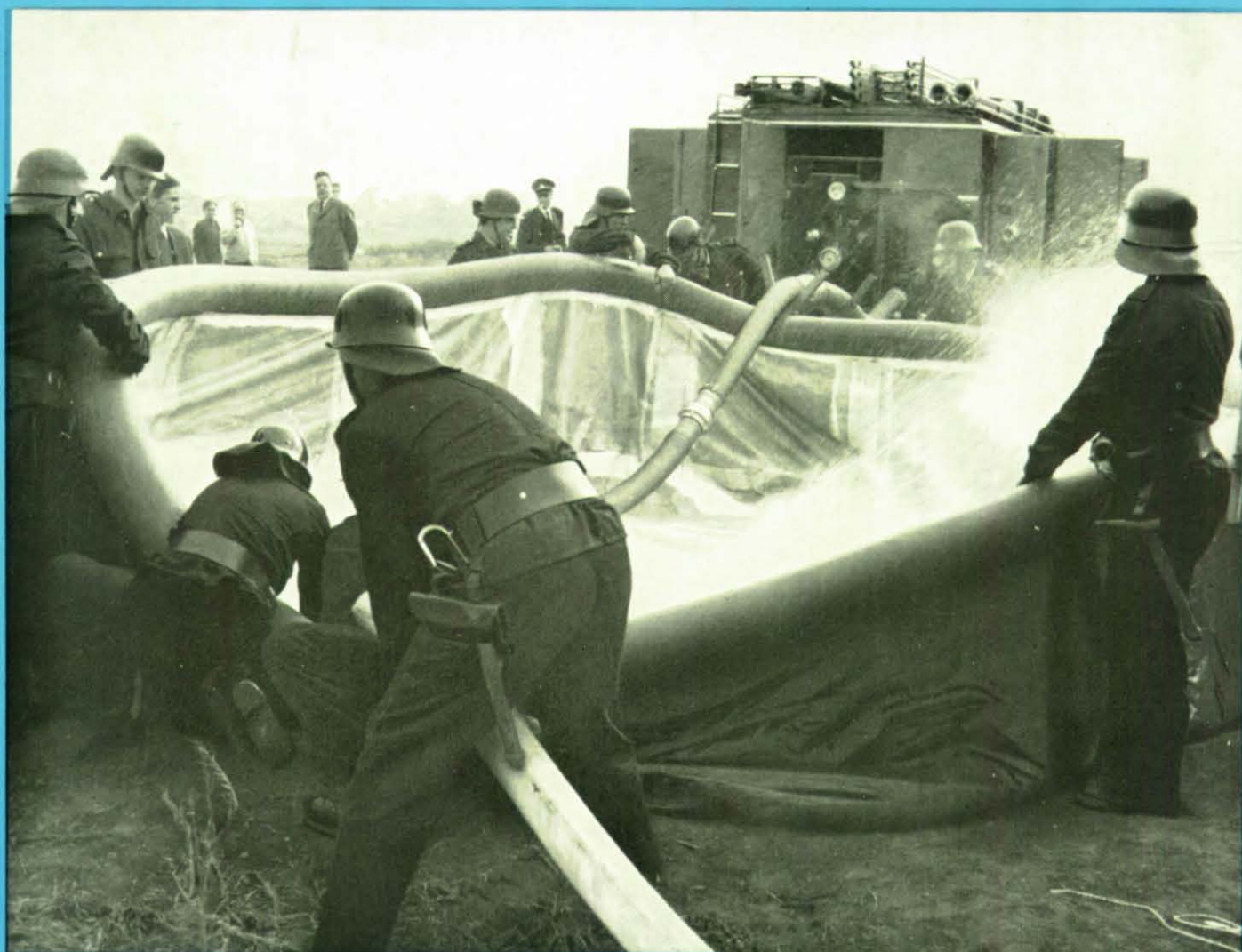
Ein 20 cbm fassender Löschwasserbehälter der neuen Wasserförderbereitschaft des LSHD Bonn wird gefüllt.
