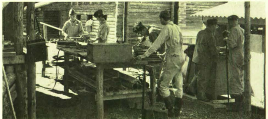
Auch die Schaffung eines Provisoriums verlangt technisches Können. Hier wird der Rauchabzug für die Ölheizung geschweißt.
