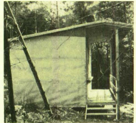
Küchengebäude mit Ausgabegang, der durch Schutzwände geschlossen werden kann.
