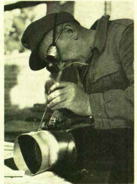
Auch die Schaffung eines Provisoriums verlangt technisches Können. Hier wird der Rauchabzug für die Ölheizung geschweißt.
