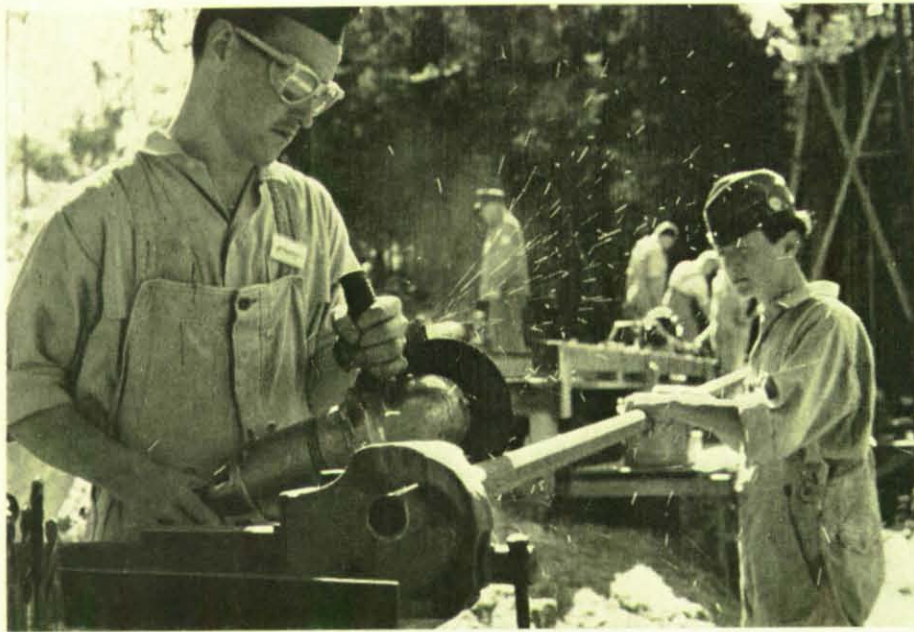
Bild unten: THW-Helfer schweißen einen Siederohr-Rahmen für die Öl-Preßluftheizung des Warmwasserbereiters für das Lager.
