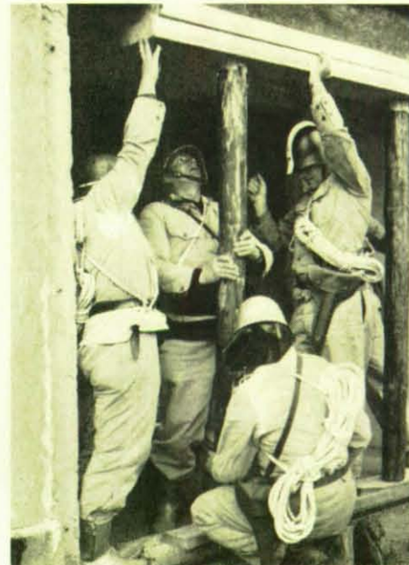
Oben: Das fachgerechte Abstützen einsturzfährdeter Gebäudeteile erfordert maßgerechte Arbeit.
