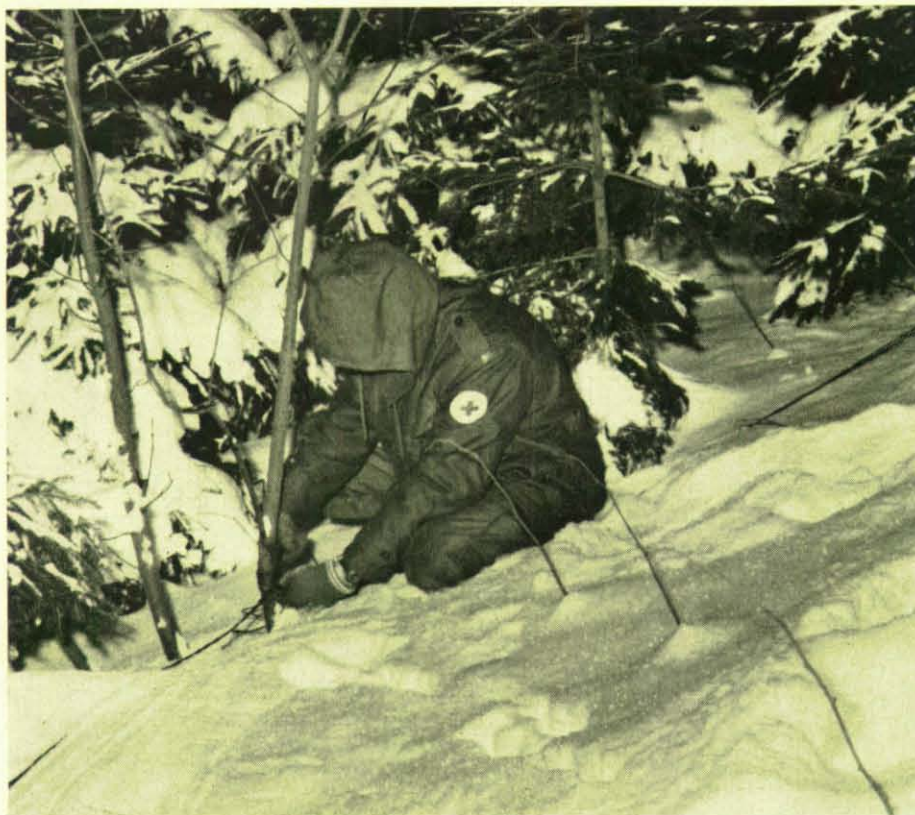
Oben: Auch Nachtübungen sind in dem Ausbildungsplan enthalten. Helfer verlegen auf dunkler Straße eine Feldkabel-Doppelleitung.
