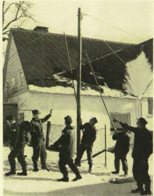
Oben: Hier wird der Feldkabelbau durch eine Ortschaft vorgenommen. Kabelausleger und Drahtgabler arbeiten nach Weisung des Gruppenführers.
