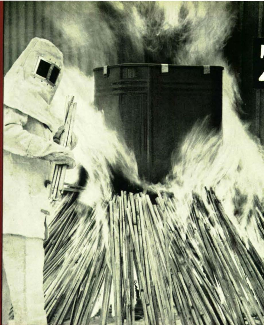
**Oben:** Seine Feuertaufe besteht hier ein brandsicherer Kunststofftank. Er verbindet die Korrosionssicherheit des Kunststoffes mit der Brandsicherheit des Stahls.
