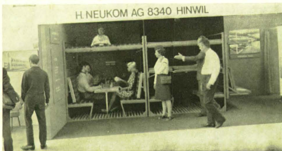
Links: Schutzraum im Keller mit acht Schlafstellen oder – mit wenigen Handgriffen umgebaut – als Tagesaufenthaltsraum.
