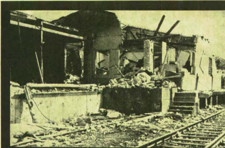
Von oben nach unten: Der vom Luftdruck verwüstete Güterschuppen. — Feuerwehrmann beim Löschen eines in Brand geratenen Güterwaggons. — Rest eines Waggons, der mit dem Unglückswaggon gekoppelt war. — Zivilschutz-Helfer beim Aufräumen in dem Verladeschuppen.
