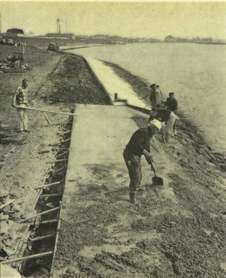
Links: Nach der Beseitigung von Sturmflutschäden wurden überall an der Nordseeküste, wie hier in Bremerhaven, die Deiche gesichert. Mitte: Auch in unserem Lande gibt es erdbeben-trächtige Zonen. Folgen wie die des Erdbebens von Agadir im Jahre 1960 sind uns jedoch fremd. Unten: Am Rande des Eingeborenenviertels von Agadir haben sich Überlebende ein Notlager eingerichtet, wo sie auf Versorgung und ihre Evakuierung warten.
