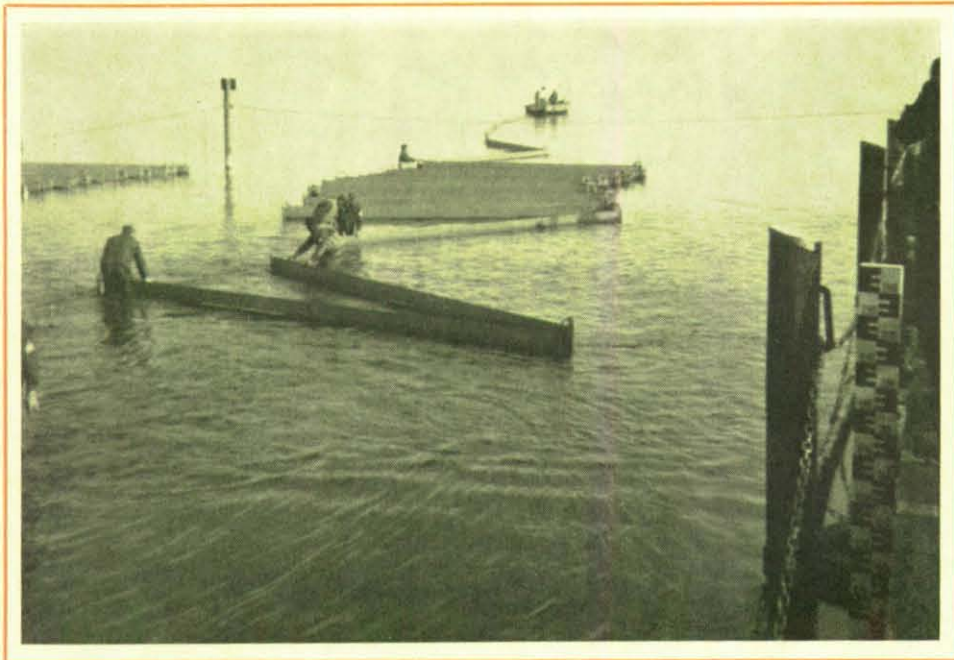
Oben: Teilstücke der „Linzer Sperren“ werden von THW-Helfern an die Achemündung gefahren.
