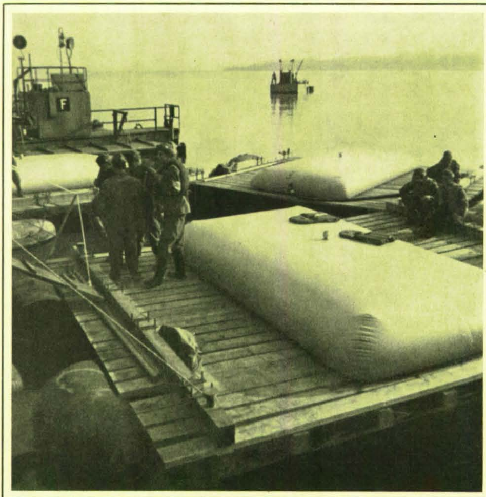
Auf vom THW gebauten Fähren wird das abgesaugte Öl in Faltbehältern — 10 bis 12 t — zur Umfüllstation am Landesteg Feldwies transportiert.
