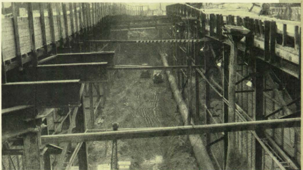
Oben: Für alle Strecken wurde die offene Baugrube gewählt, die bis zu 20 m Tiefe erreichte. Hier stellte die Grundwasserabsenkung eine besondere Schwierigkeit dar.
